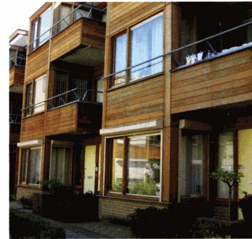
Al een hele verbetering. Het hout is gestraald en ziet er zonder verdere bescherming al prima uit. Het stralen gaf geen enkele overlast
