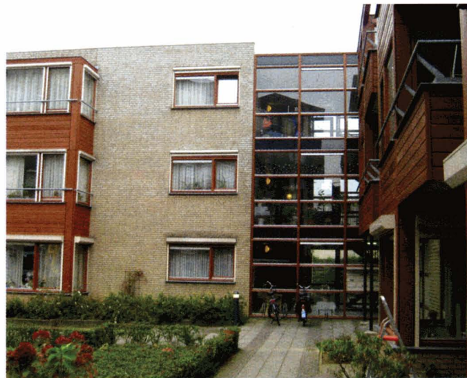
Het hout is behandeld met een dekkende beits. Geen reden meer tot klagen van de bewoners en van de woningcorporatie
